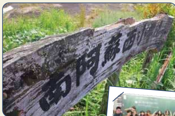
経年劣化が目立つ看板
