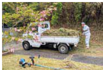
熱中症対策をしながらの現場作業
