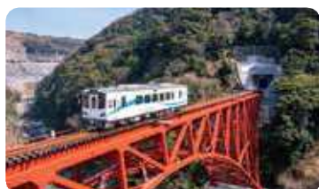
第一白川橋梁
