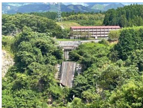
図 1-21 熊本地震で崩壊した旧阿蘇大橋
