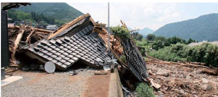
土砂で押しつぶされた井川さんの自宅
