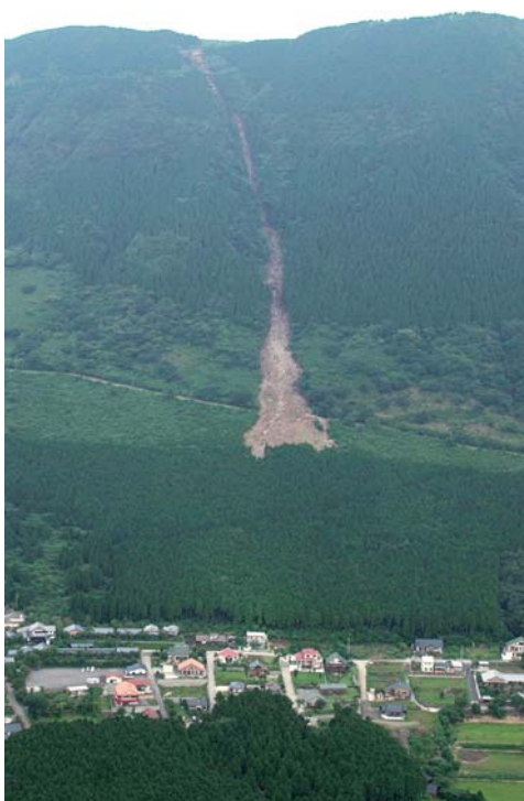
土砂が押し寄せる赤瀬地区
