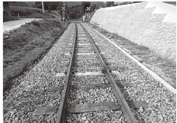
長陽駅～中松駅間 復旧した線路軌道
