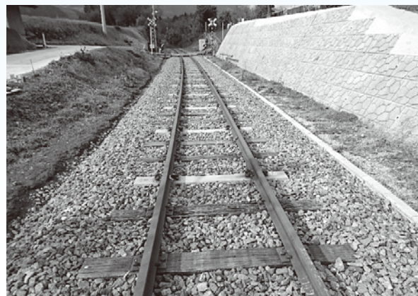
長陽駅～中松駅間 復旧した線路軌道
