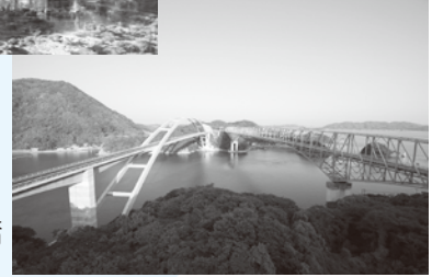
天城橋および天門橋
