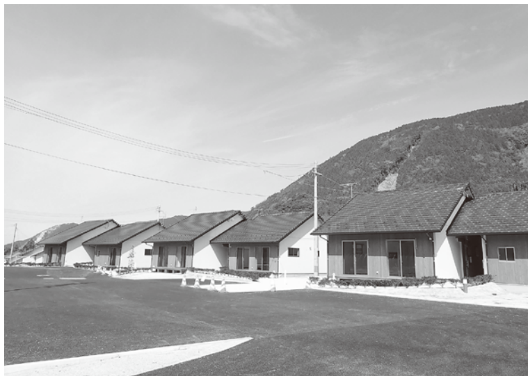
災害公営住宅：木造、平屋 40戸 集会所：木造、平屋 約80平方メートル
