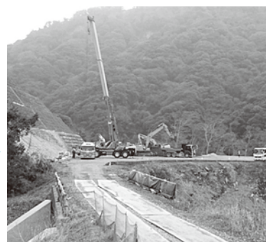
現在（復旧工事中）
