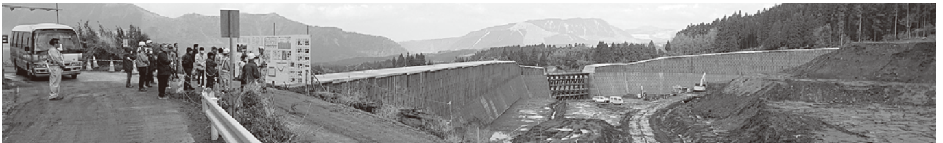
長野地区に建設されている、長さ271メートル、高さ14.5メートル砂防えん堤（三王谷川2）
