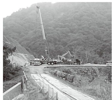
現在（復旧工事中）
