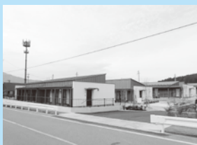
新しく加勢地区に建設された下西原第1団地
