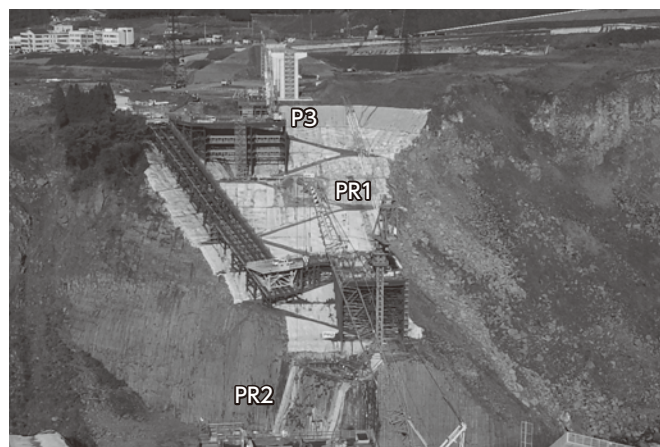
阿蘇大橋の下部工 (基礎工) 工事をしています。
