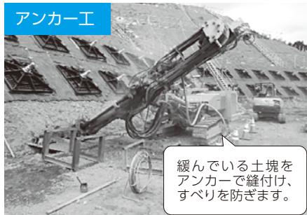
鉄筋挿入工
