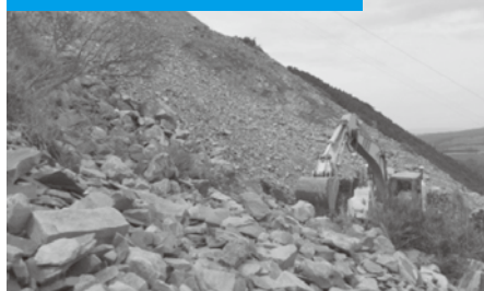
崩壊土砂の撤去に向けた作業 （作業用道路の造成）
