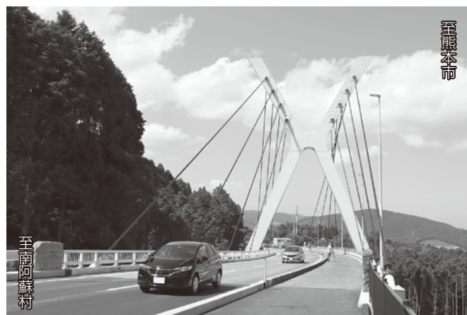
▼桑鶴大橋と周辺の状況写真 (撮影日：平成30年7月20日)
