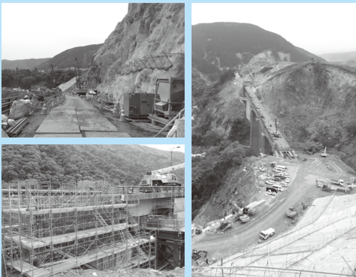
今夏の復旧を目指し工事が進められる「阿蘇長陽大橋」
