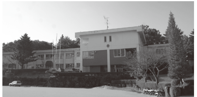
くまもと清陵高校の校舎として活用される旧久木野中学校校舎
