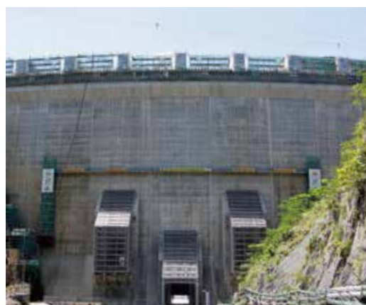
完成した阿蘇立野ダム
