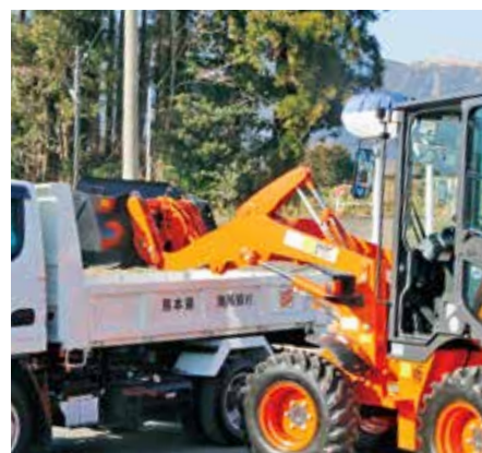
ホイールローダからスライドダンプへ積み降ろし作業
