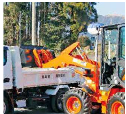
ホイールローダからスライドダンプへ 積み降ろし作業
