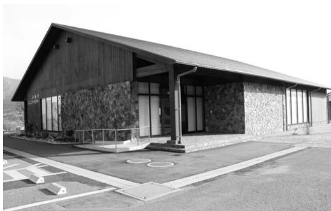
完成した「みなみあそコミュニティセンター」
