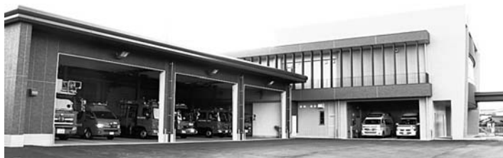
完成した新庁舎
