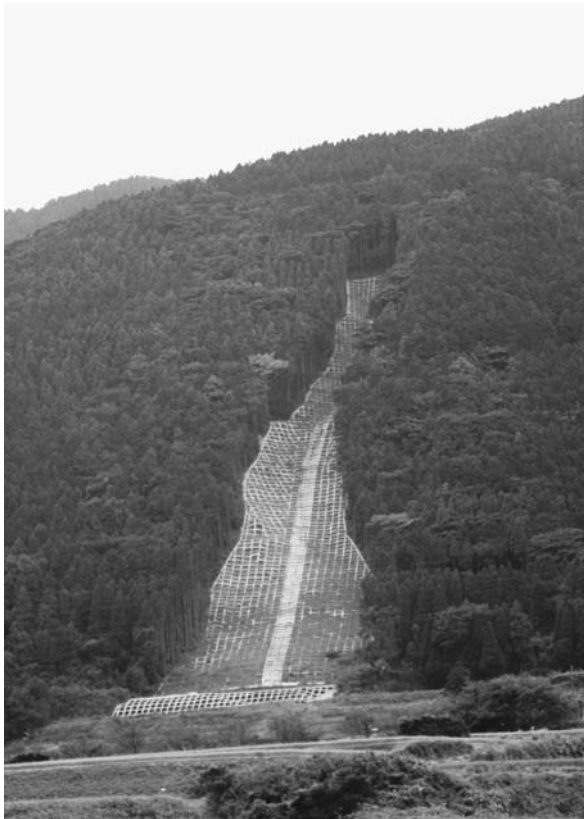
復旧工事が終了した災害現場（立野地区）
