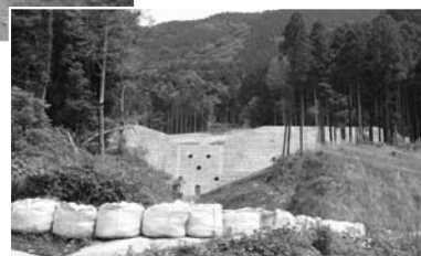
復旧工事が進む災害現場
