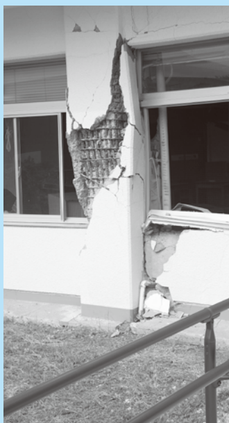
上: 耐震補強の有無について (地震直後の写真) 左: 断層が直下を通過して破壊された柱
