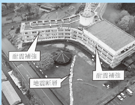
上: 耐震補強の有無について (地震直後の写真) 左: 断層が直下を通過して破壊された柱
