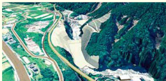
② ダムを支えるのに必要な硬い岩盤を出すために山の表面にある土や弱い岩盤などを取り除く作業を実施
