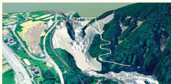
③ ダム本体を形成するコンクリートの打設実施
