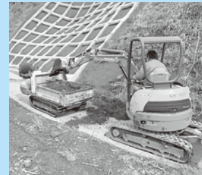
土をかき出している様子
