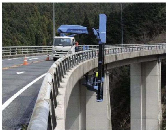
(橋梁点検車を使用)
