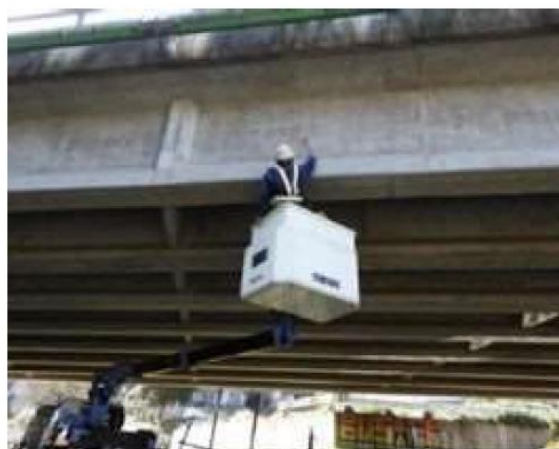
(高所作業車を使用)
