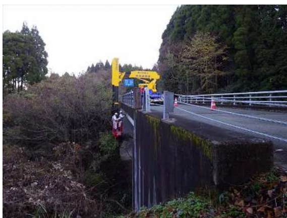
橋梁点検車使用
