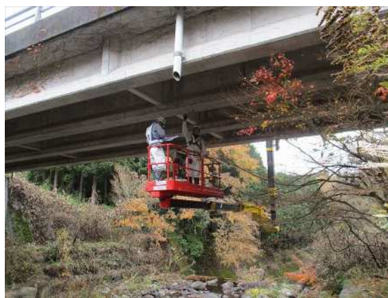
橋梁点検車使用
