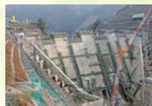
もうすぐ完成、立野ダム
