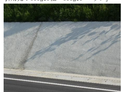
コンクリート舗装
