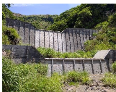
コンクリートクローズ堰堤 (型枠材張)
