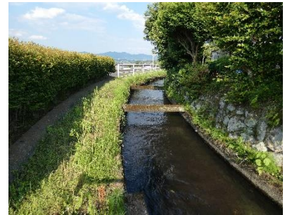
石積みのある水路
