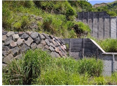
自然石による護岸石積
