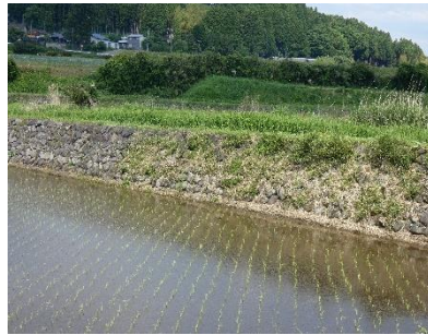
石積のある法面
