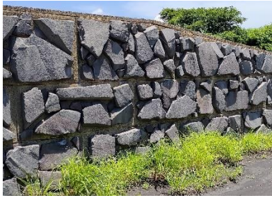
自然石貼りの表面処理
