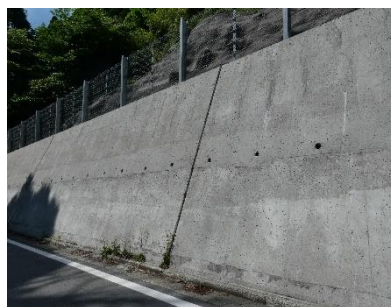
コンクリート擁壁
