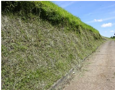
草刈後の法面
