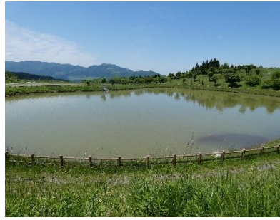
沢津野ため池
