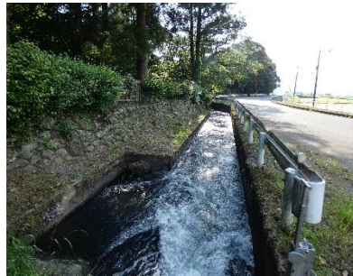
石積みのある水路
