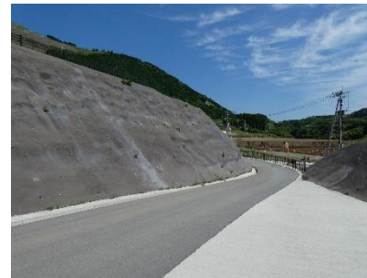
吹付工（明度を低下させている。）
