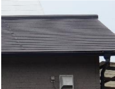
切妻屋根(ガルバリウム鋼板)
