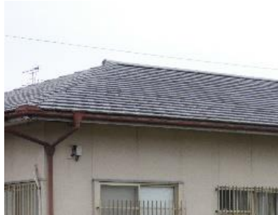
寄棟屋根(ストレート)
