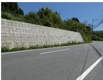
ブロック積擁壁
