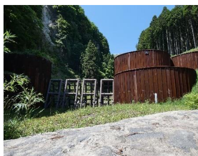
鋼製セル+鋼製スリット (B型) 堰堤
