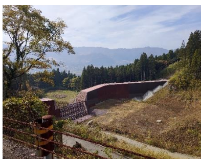
コンクリートクローズ+鋼製スリット (格子型) 堰堤 (茶色塗装)
