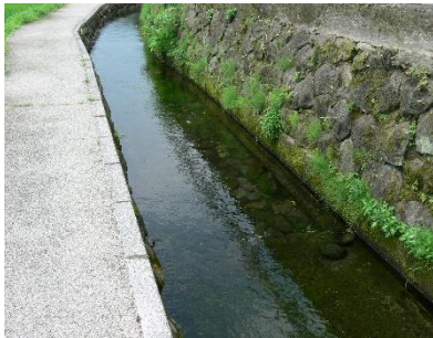
底に意図的に石を敷いている水路
