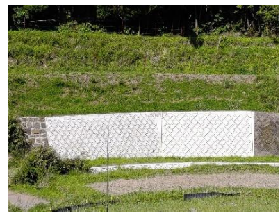
間知ブロックのある法面
