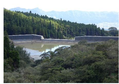
コンクリートクローズ堰堤
