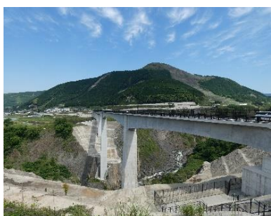
PC4径間連続ラーメン箱桁橋
