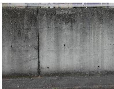
コンクリート打設
