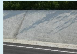
コンクリート舗装
