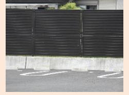
色に配慮したアルミ製フェンス
