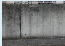
コンクリート打設
