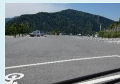
広大な面積のアスファルト舗装
