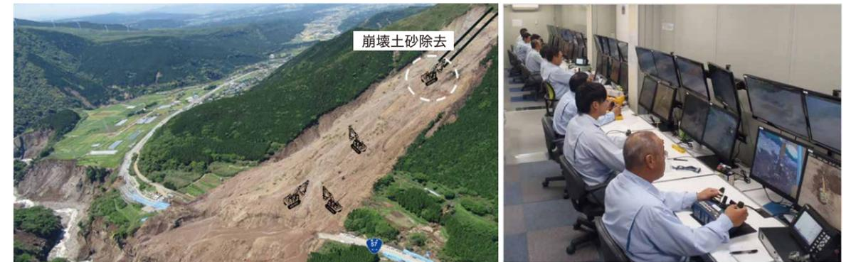
斜面上部には不安定土砂が残っており、余震によって崩壊する危険をはらんでいた。そこで二次災害防止に配慮しながら、斜面中腹に土留盛土の施工工事および不安定土砂の撤去を行った。当作業では雲仙普賢岳の砂防事業等で培われた無人化施工技術が活かされ、最大14台/日の無人化施工機械を稼働。その結果、安全性とスピード感を両立しながら復旧工事を進めることができた。
