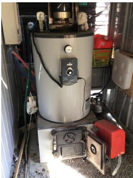
図表 58 薪ボイラー（左）と燃料の廃材（右）
