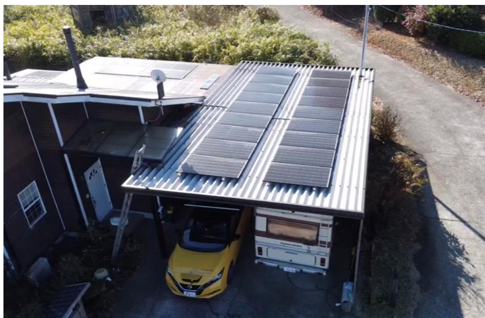
図表 55 太陽光パネル（全体で 6kW）
