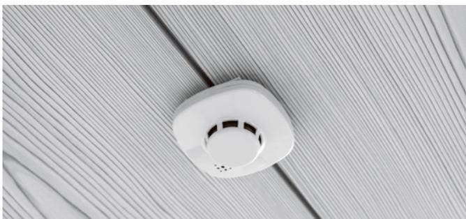
住宅用火災警報器は、設置から10年が経過すると電池の寿命や電子部品の劣化などで不具合が発生しやすくなります。そのため、設置後10年を目安に交換することをオススメします。また、火災警報器にホコリがついていると火災を感知しにくくなります。年末の慌ただしい時季になりますが、「いざ」という時にきちんと動くよう、この機会にぜひご家庭の火災報知器の作動点検と掃除をおこないましょう。
