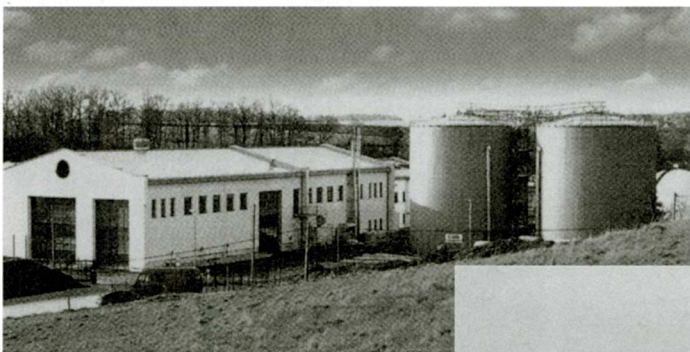
▲メタン発酵プラント施設
