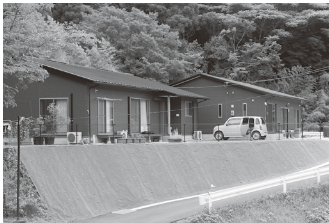
新たに整備された南阿蘇村移住定住促進住宅喜多住宅は移住者にも好評
