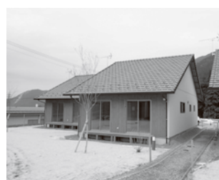
立野地区に整備した災害公営住宅馬立団地
