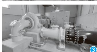
①発電に使われる水路 ②施設の恒久の安全を願います ③用い水路の水で水車が回転して発電機を回し発電します
