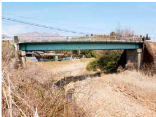
橋梁補修対象場所
