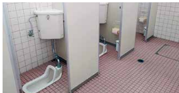
避難所トイレの現状
