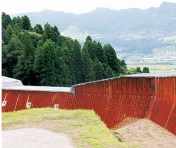
完成した東下田2第2砂防堰堤
