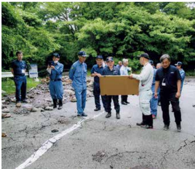
村道久木野～西原線の被害状況の確認
