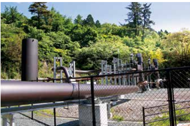
完成した湯の谷発電所
