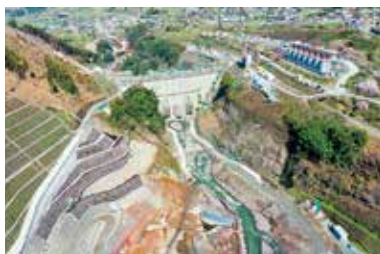
立野ダム上流側
