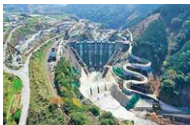
立野ダム下流側
