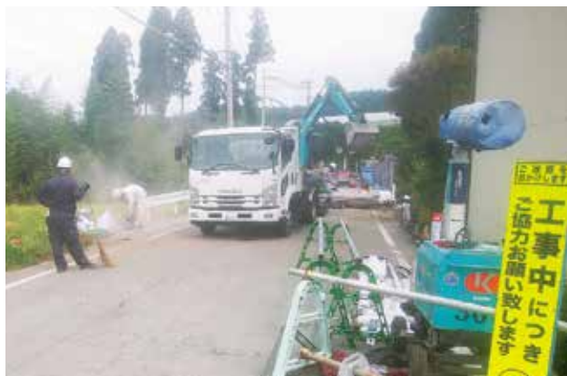
改修中の妙見橋
