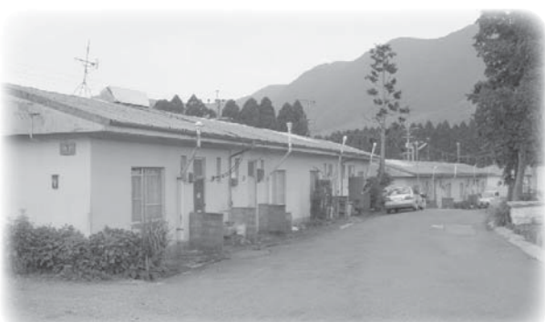
公営住宅関連維持補修工事 1,350万円
