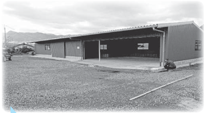
農業用施設災害復旧工事 (12億円)
