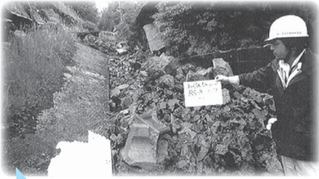
地域防災がけ崩れ対策・宅地耐震化推進工事 (3億2475万円)
