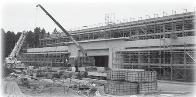
防災拠点として期待される建設中の新庁舎
