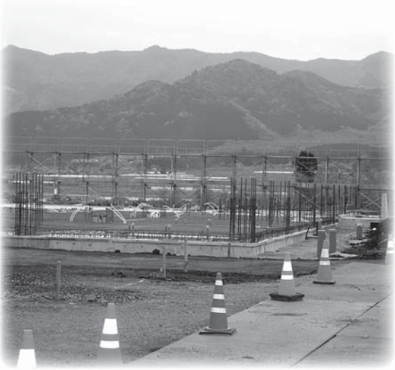
新庁舎建設現場（4月20日撮影）
