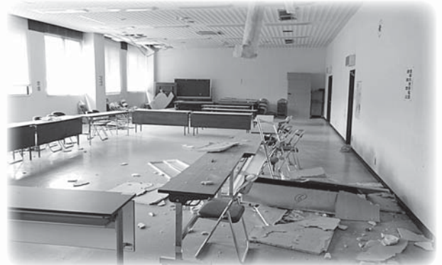
地震で崩落した集会ホールの天井
