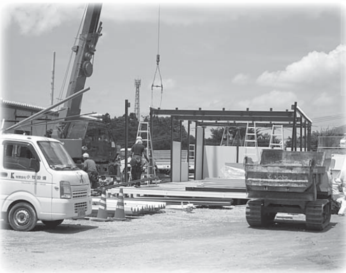
建設が進む仮設住宅（大津町室南出口）
