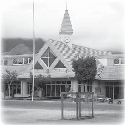
空調が整備される白水保育所
